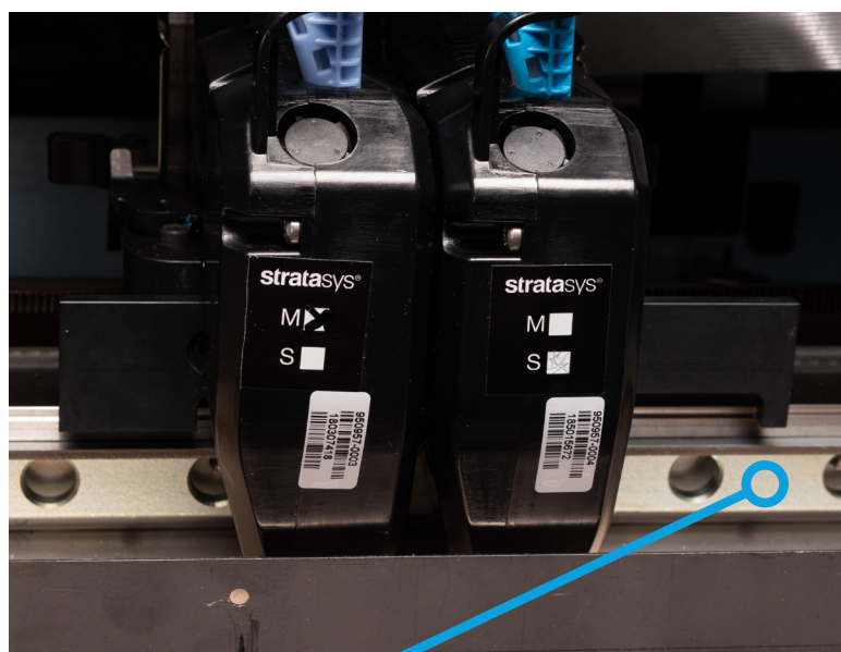
头部导轨工字钢梁加固
